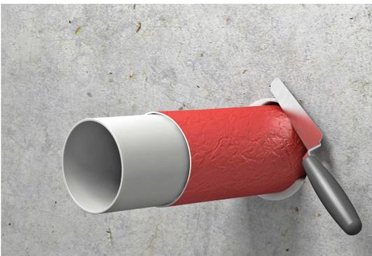
Abschliessend den Ringspalt um das Rohr im Bauteil mit Mörtel oder Gips verfüllen.
